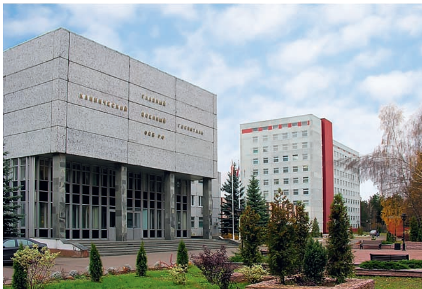
РЕКОНСТРУКЦИЯ СТАРЫХ КОРПУСОВ И СТРОИТЕЛЬСТВО ДВУХ НОВЫХ СТОЯТ В ПЛАНАХ НА БУДУЩЕЕ
