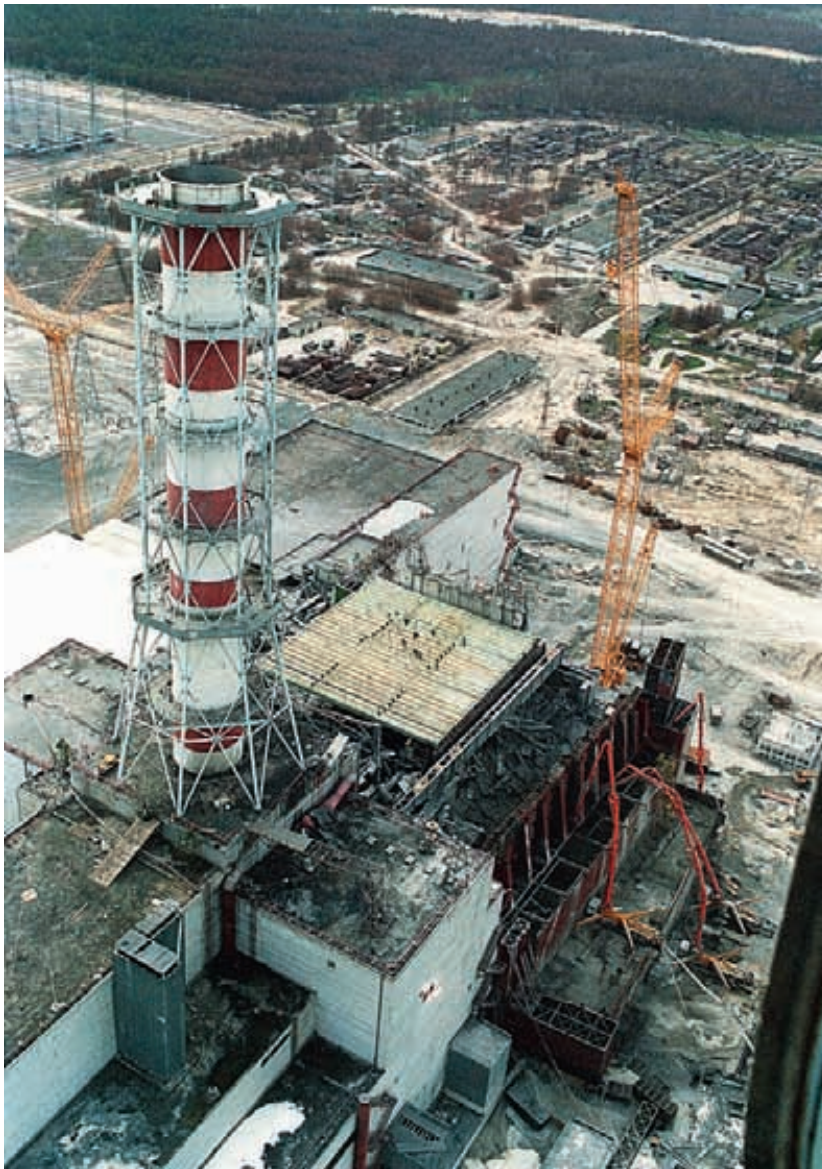
РАЗРУШЕННЫЙ ВО ВРЕМЯ АВАРИИ БЛОК ЧЕРНОБЫЛЬСКОЙ АТОМНОЙ ЭЛЕКТРОСТАНЦИИ
