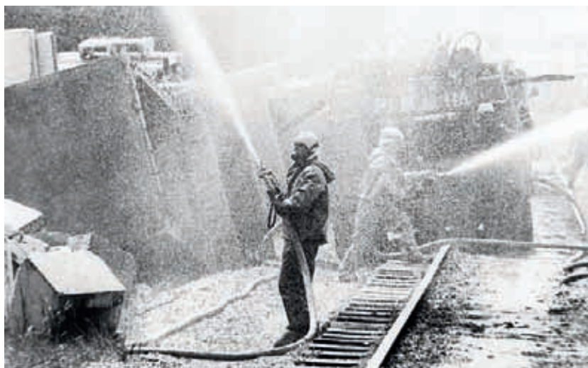
ОБРАБОТКА ТЕРРИТОРИИ ЧЕРНОБЫЛЬСКОЙ АТОМНОЙ ЭЛЕКТРОСТАНЦИИ ДЕЗАКТИВИРУЮЩИМ РАСТВОРОМ
